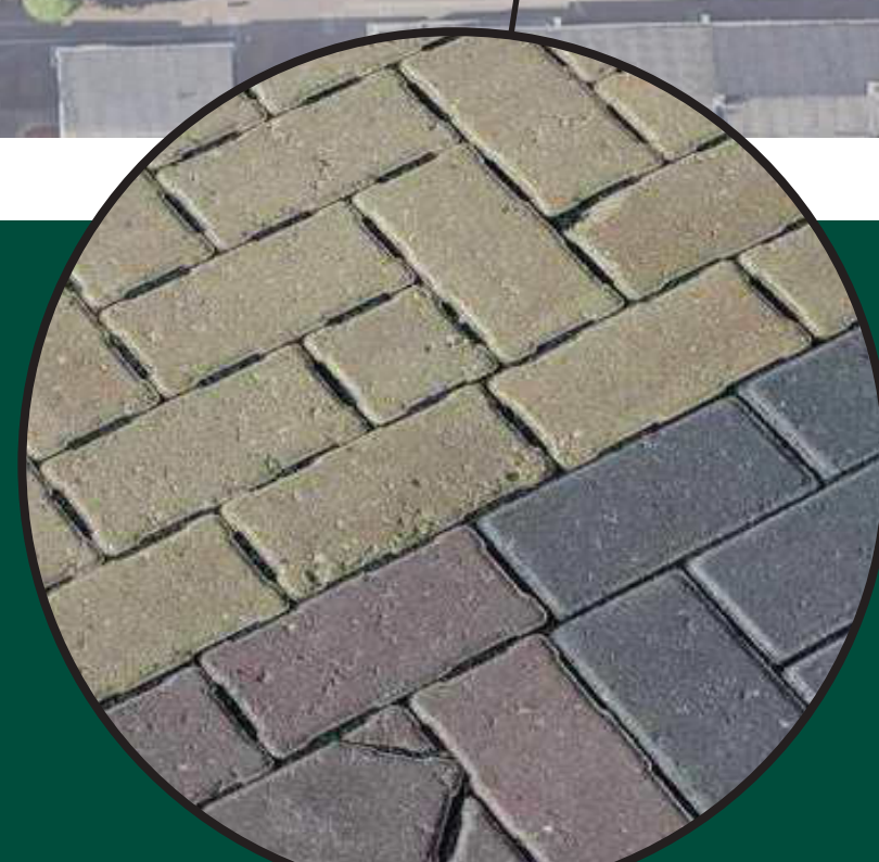
H2o betonstraatstenen met waterdoorlatende fundering.
